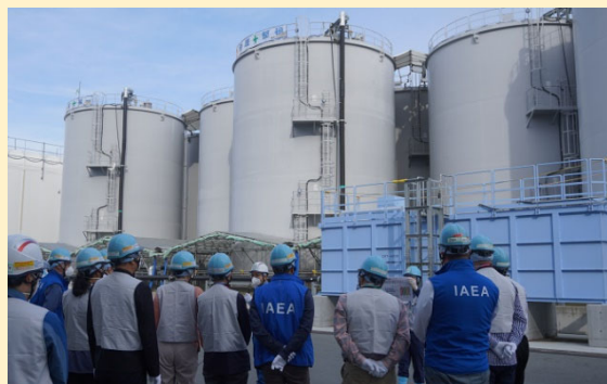
視察測量、確認用的儲槽群 (2023年10月25日 福島第一核電廠)
