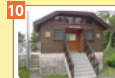
10 浄化槽のついた公衆トイレ 15ヶ所のうち7ヶ所を維持・管理しています。
