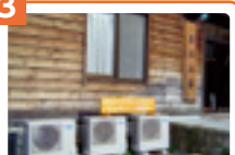
至仏山荘のエコキュート 尾瀬の空気の熱でお湯を沸かし、お風呂等に利用しています。
