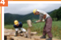
木道・ベンチの整備 尾瀬国立公園内65kmの木道のうち、20kmを東京電力が整備しています。
