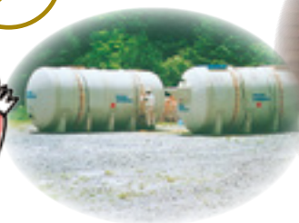
富士見峠に設置した浄化槽
