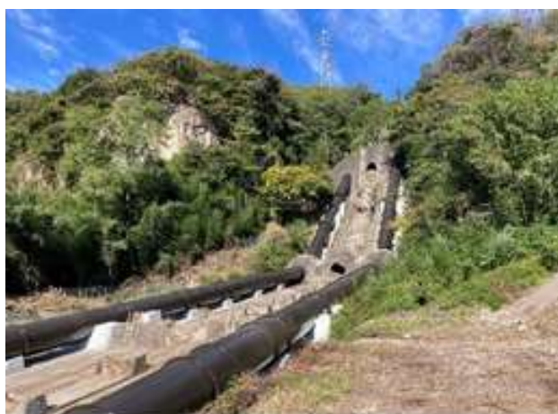
水圧鉄管（工事後）
