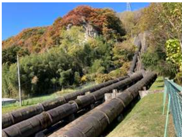
水圧鉄管（工事前）
