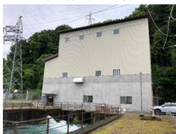
発電所全景（工事後）
