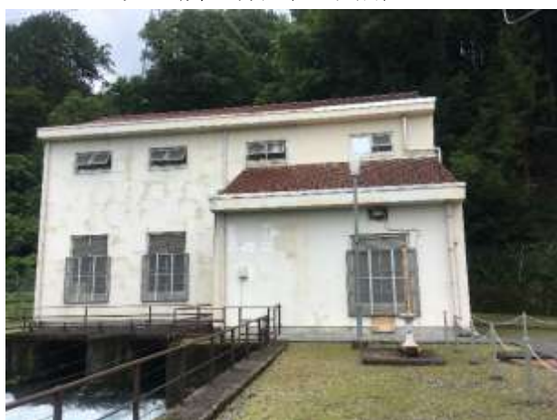
発電所全景（工事前）
