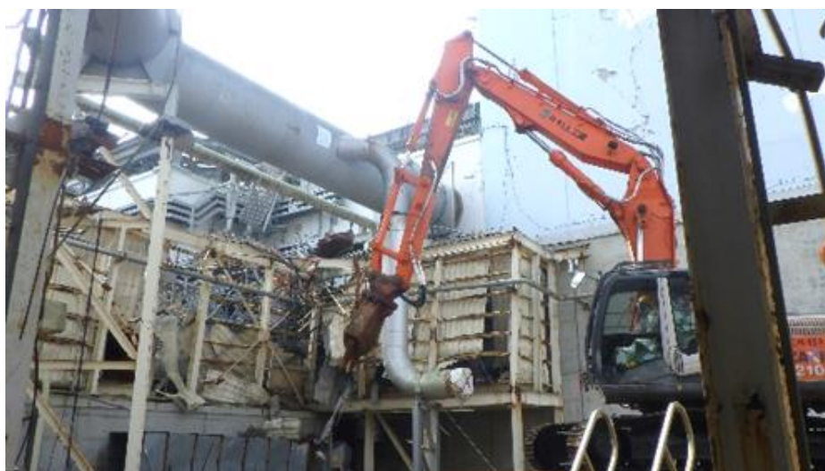
図 11 ガレキ撤去作業
