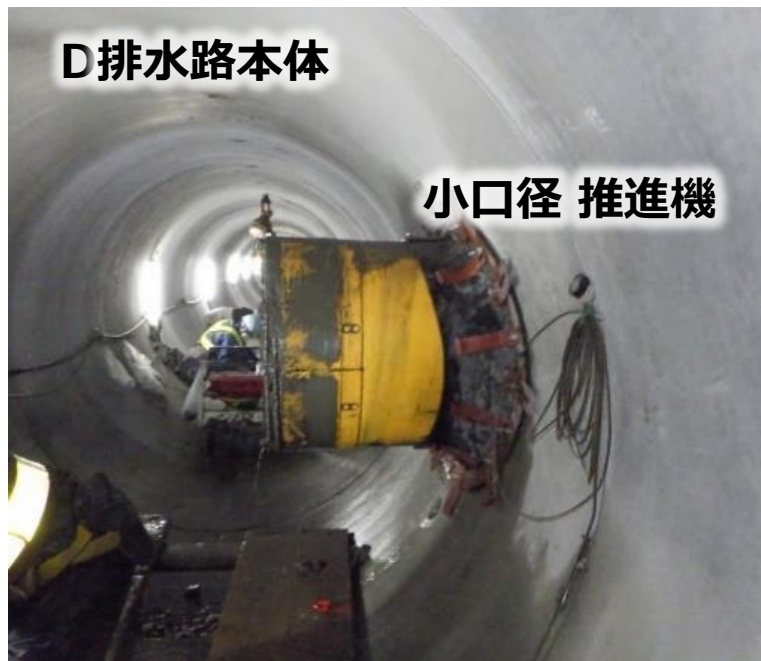
図 5 D排水路の施行状況
