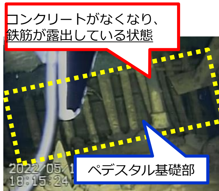
図 13 ペDESTAL基礎部付近の状況
