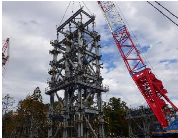
図 8 鉄骨ユニット接合確認状況(2022年11月)
