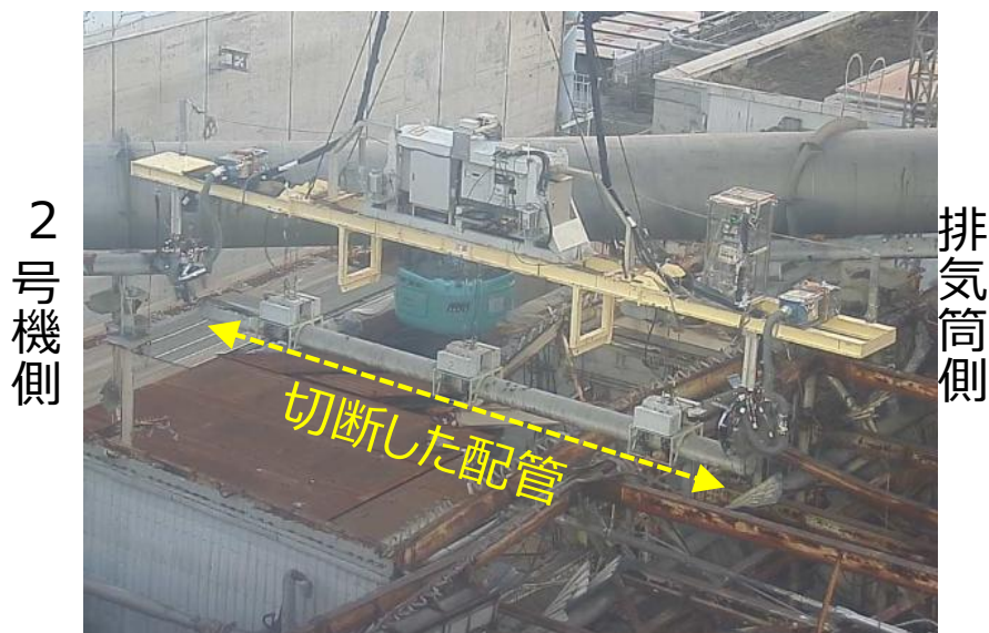
図 10 配管切断作業
