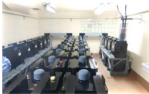
所内蓄電式直流電源設備
