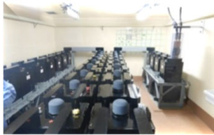
所内蓄電式直流電源設備
