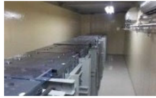
所内蓄電式直流電源設備
