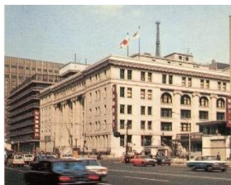
旧 第一勧業銀行本店ビル
