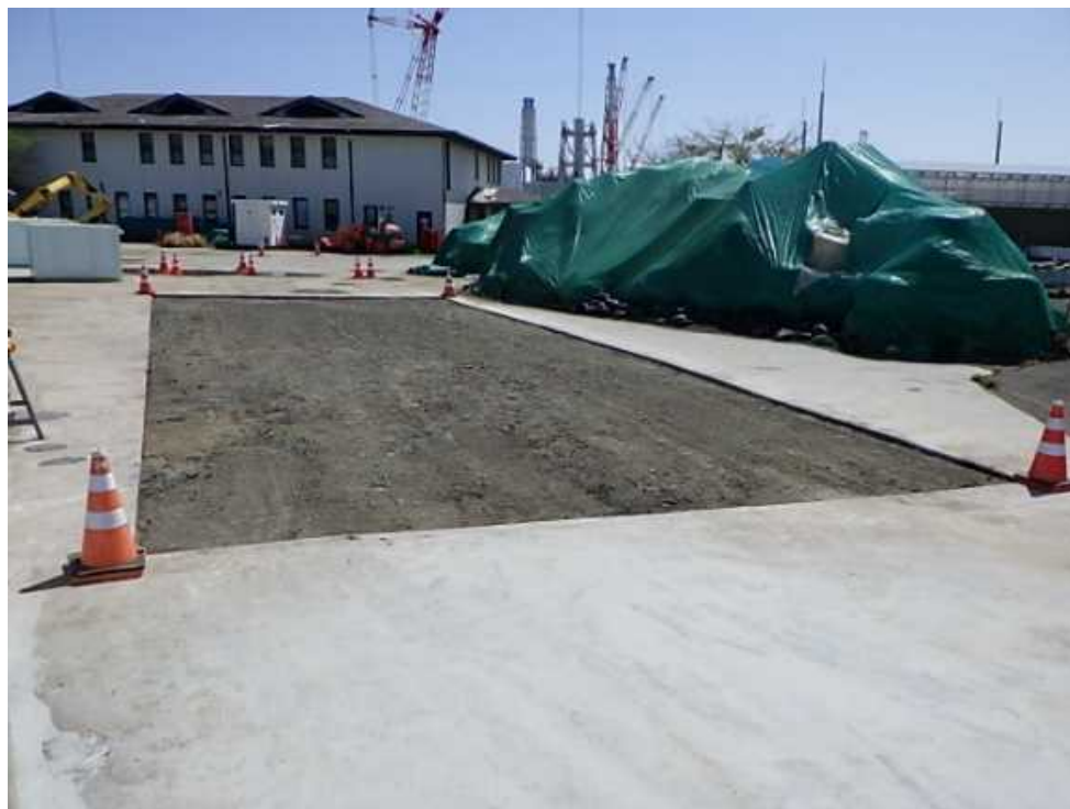
アスファルト舗装はぎ取り（4月15日）（ 70\mu\text{m} 線量当量率が高い箇所）
