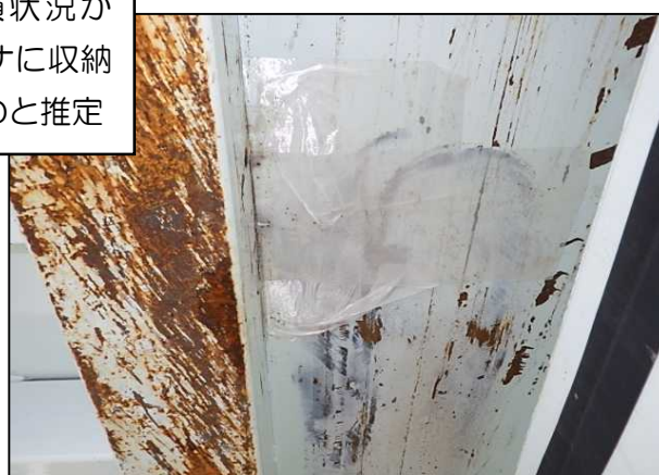
コンテナ3（補修後）
