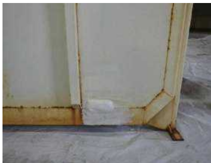
パテ埋め補修箇所
