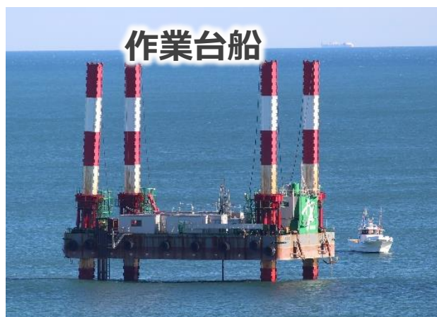
図 35 地質調査の状況
