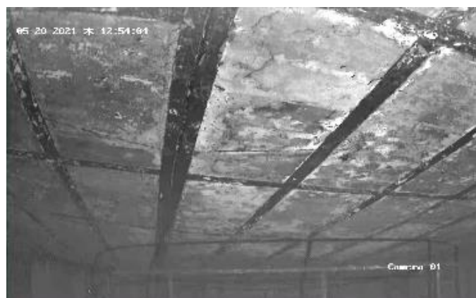
図 18 シールドプラグ下部の状況
