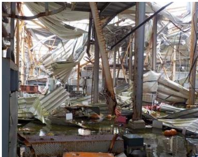
図 4 1号機廃棄物処理建屋
