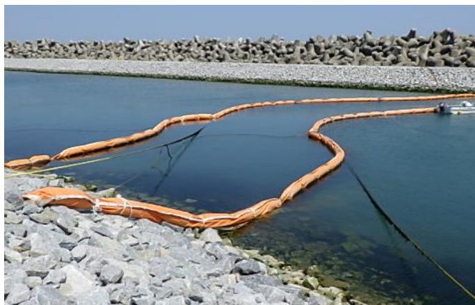
図 40 5・6号機取水路開渠シルトフェンス(既設)展張
