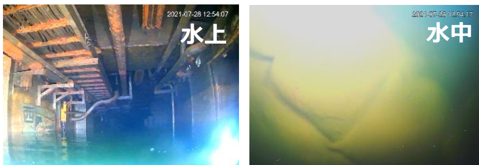
図 8 プロセス主建屋地下階の調査
