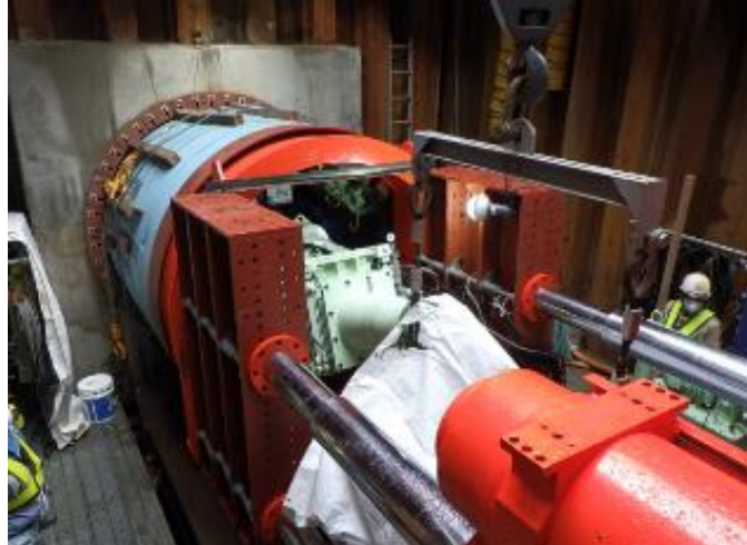
図 11 推進トンネル工法による掘進状況
