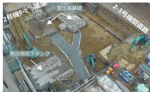
2号機原子炉建屋南側ヤード状況
