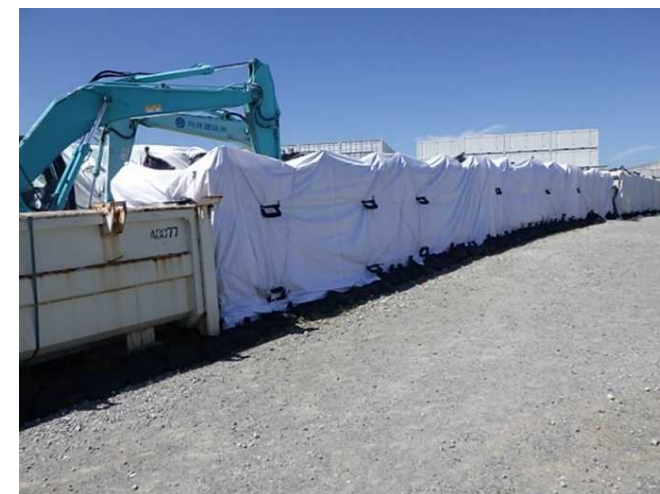
ノッチタンク仮設シート養生
