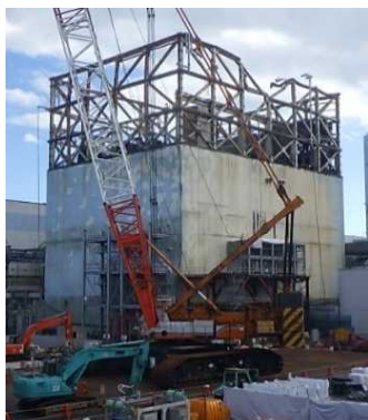
1号機原子炉建屋現場状況
