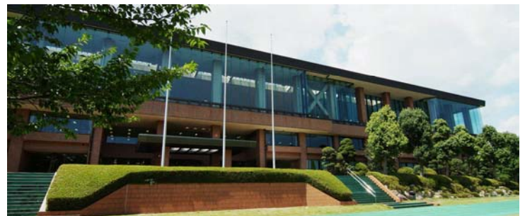
メディカルトレーニングセンター(スポーツ施設)
