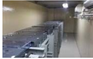
所内蓄電式直流電源設備
