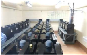
所内蓄電式直流電源設備
