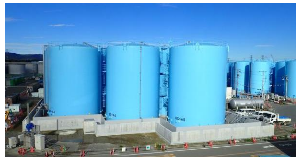
図4 溶接型タンク
