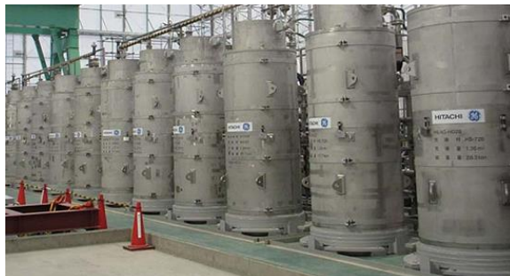
図3 高性能多核種除去設備
