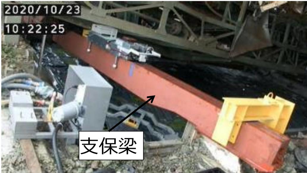
図 12 燃料取扱機支保設置状況
