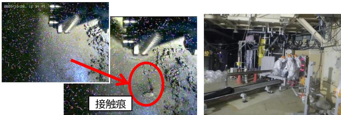
図 26 接触前後の堆積物の状況及び貫通孔前での作業状況
