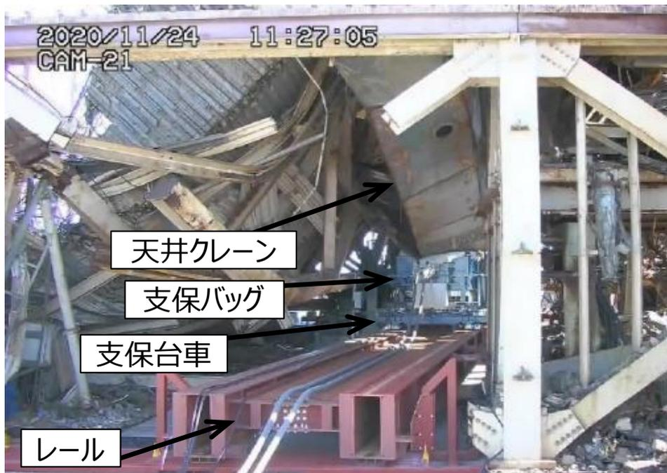
図 13 天井クレーン支保設置作業完了後の状況
