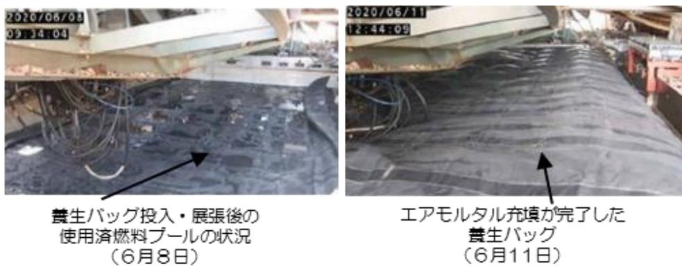
図 11 使用済燃料プール養生の概要
