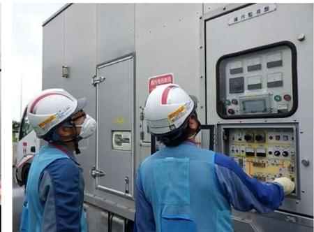
電圧・周波数調整（電源車操作訓練）
