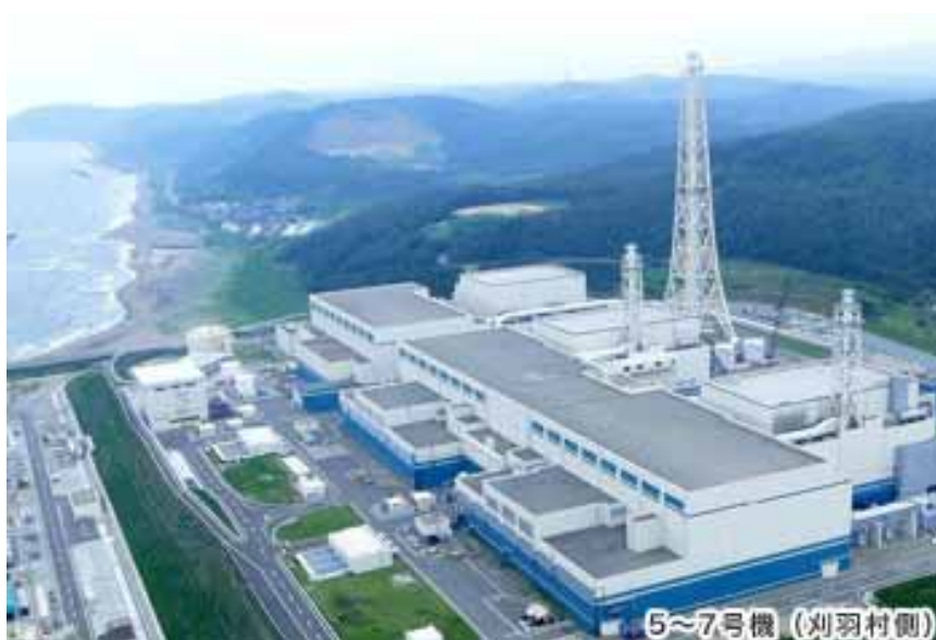
手前から 7 号機、6 号機、5 号機
