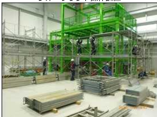
足場組立訓練
