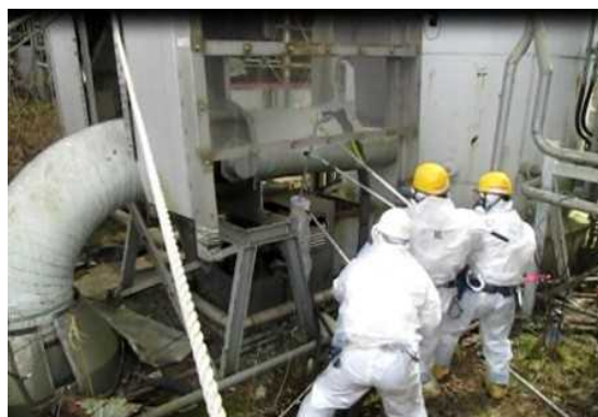
吸込み配管交換作業
