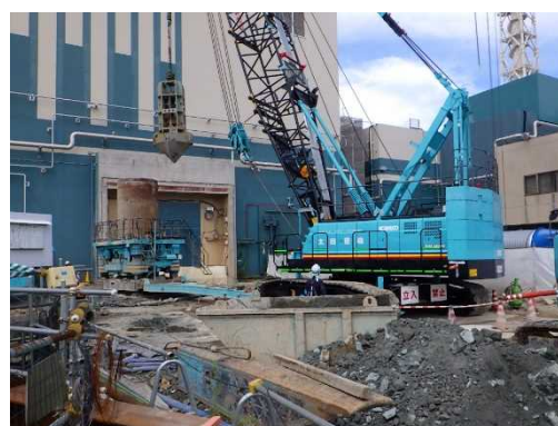
大物搬入口地盤改良
