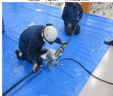
ケーブル端末処理・接続訓練
