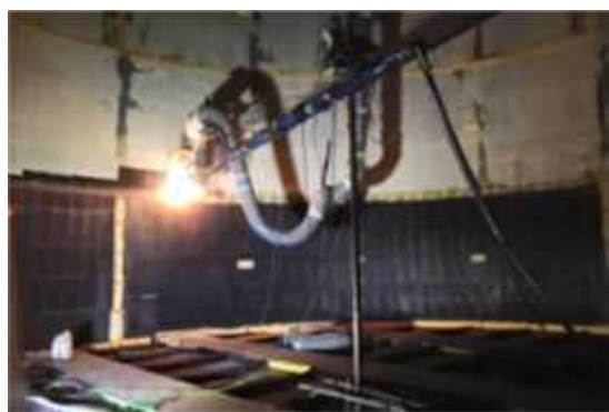
フランジタンク解体のカイゼン（福島第一） 左 タンク内部でのレーザー除染 右 タンク解体
