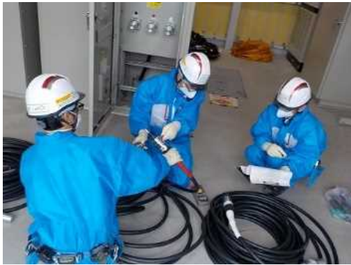
ケーブル導通確認（電源車操作・接続訓練）
