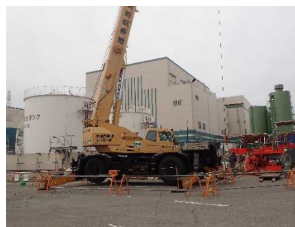
6号機軽油タンク
