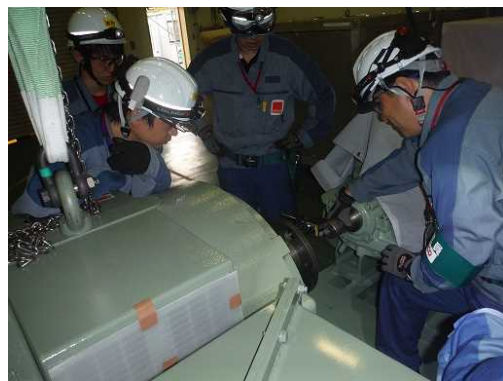
電動機取替訓練
