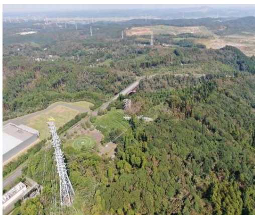
<鉄塔倒壊全景>
