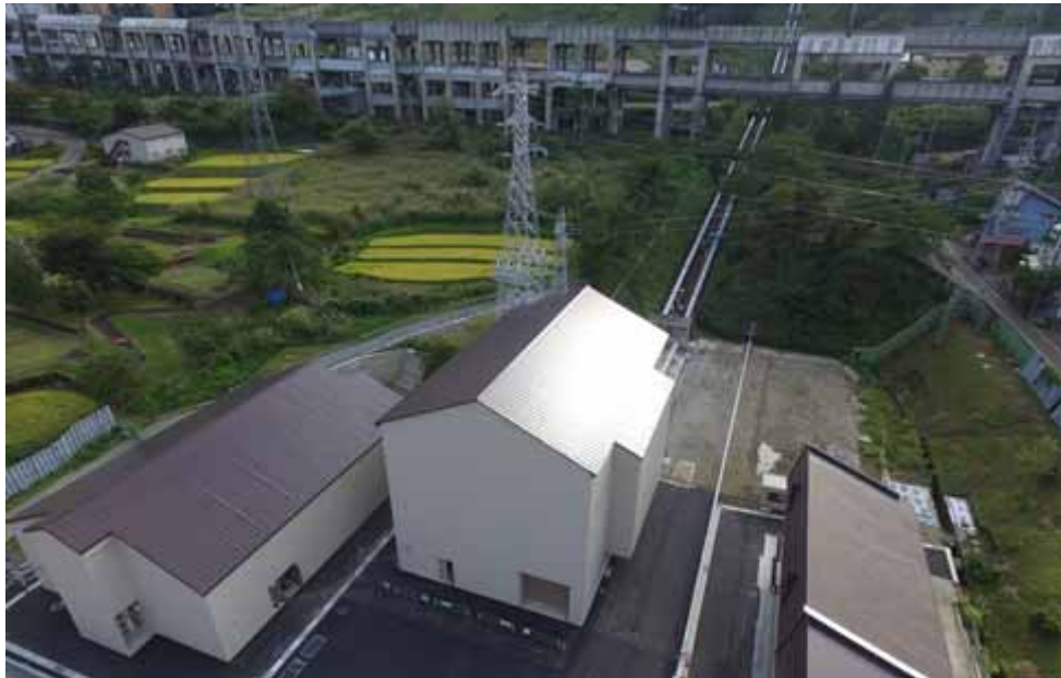
湯沢発電所外観
