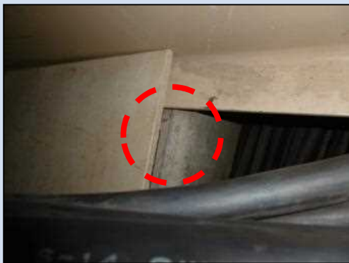
跨ぎ解消状況
