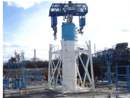
模擬排気筒の解体
