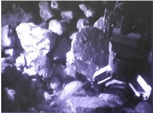
ガレキ撤去訓練
