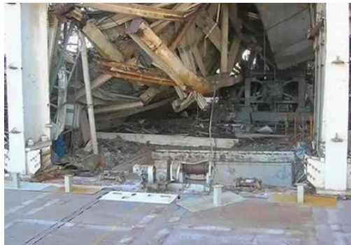
開口部（機器ハッチ）養生前
