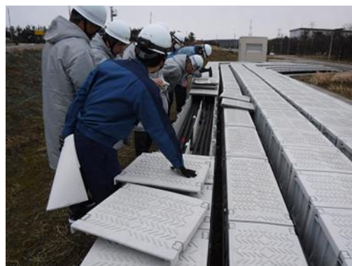
ケーブル接続部調査
