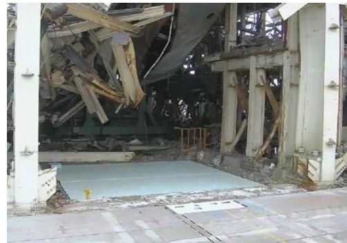
開口部（機器ハッチ）養生後
