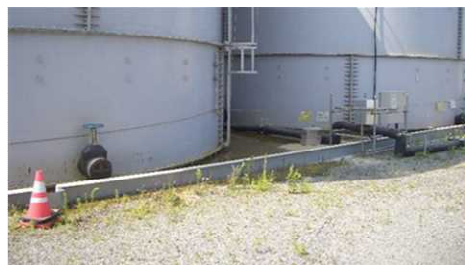
図 タンク堰の二重化・内堰の嵩上げ・堰内被覆
