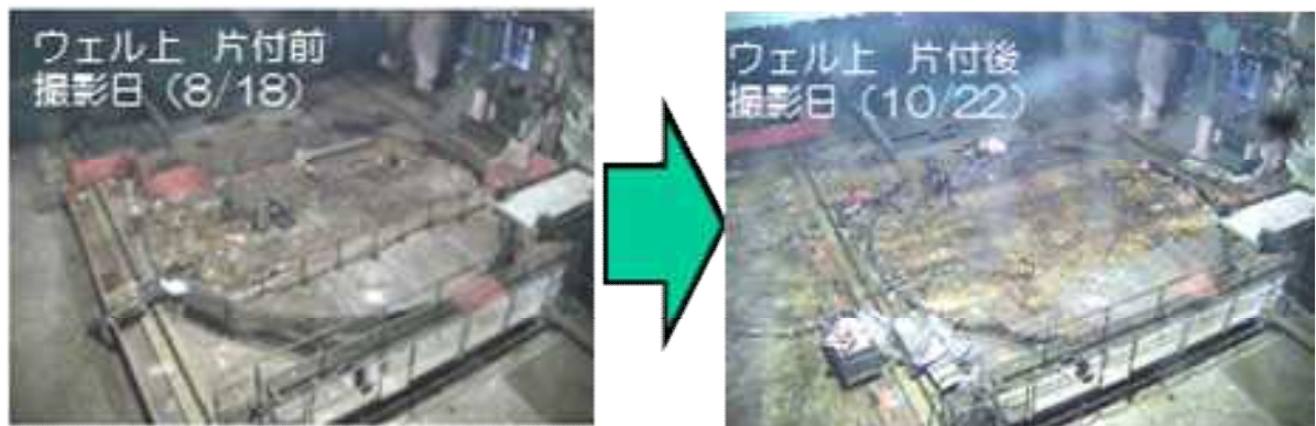
図 2号機ウェル上の片付け状況
