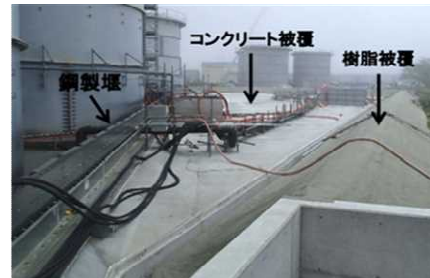
図 タンク堰の二重化・内堰の嵩上げ・堰内被覆
