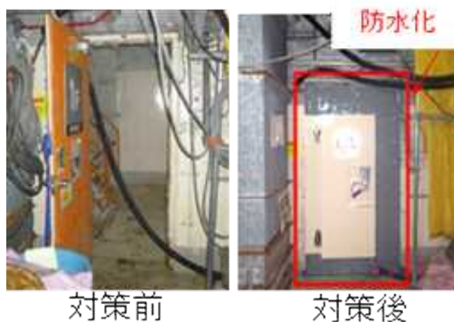
図 建屋開口部の閉止状況
