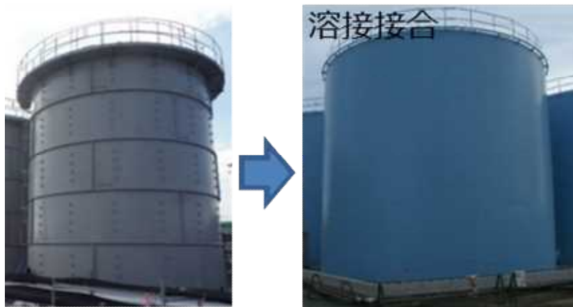
図 フランジ型タンクリプレース
