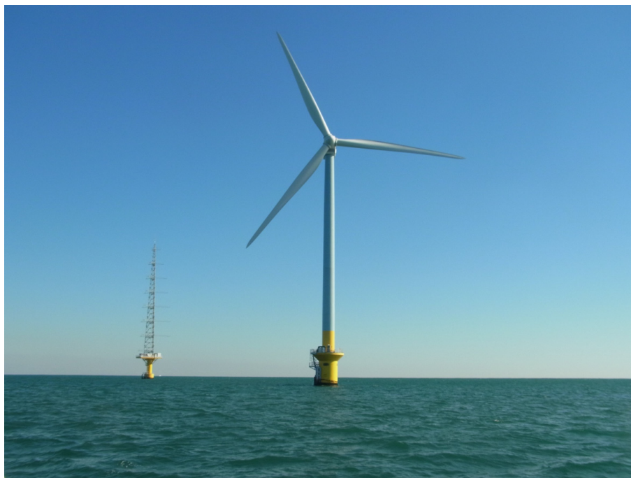
洋上風力実証設備と風況観測タワー
