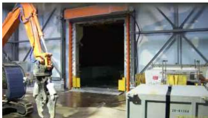
原子炉建屋西側開口部
