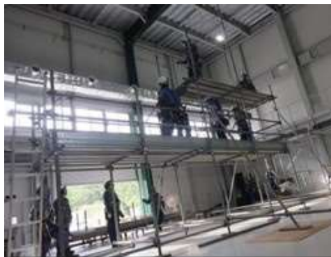
足場組立・解体訓練
