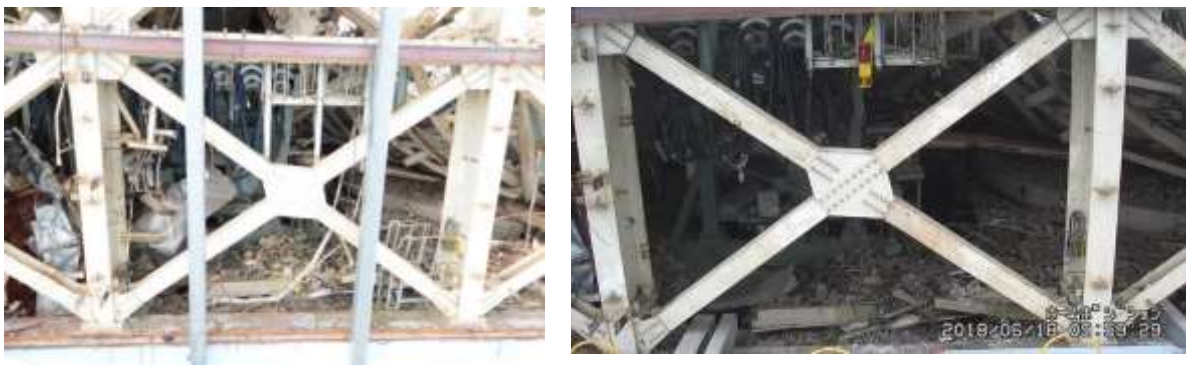
外周鉄骨の撤去（左；撤去前、右；撤去後）
