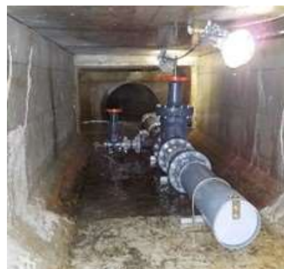
設置した逆止弁
