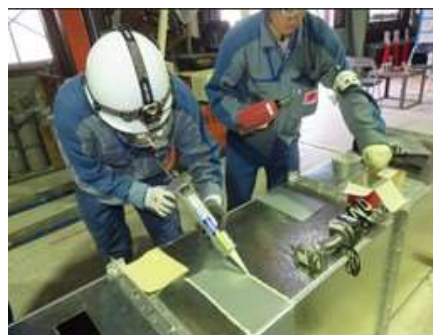
空調ダクト補修訓練
