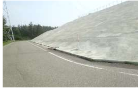
防火帯（整備完了後）
