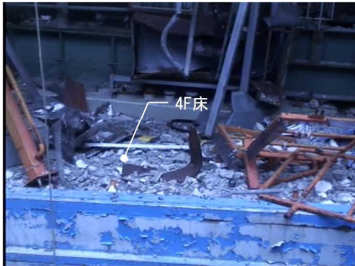
⑥4F床 (大物搬入口北側)
