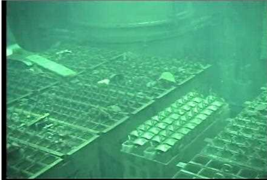
図6-1 4号機SFP内の状況（その1）
