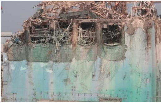
②東側壁面
