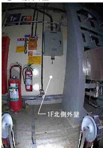
①1F北側外壁
