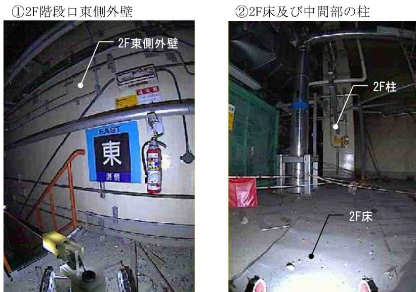
図-2.4(1) 建屋内状況写真（2階）
