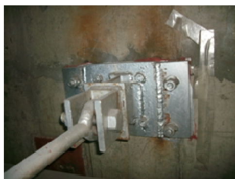
図-4 1号機の配管支持構造物の点検結果
