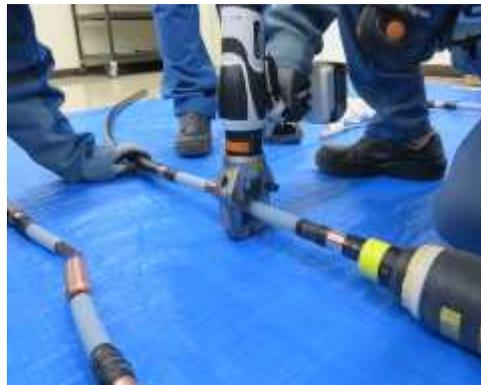
高圧ケーブル接続訓練（圧着作業）
