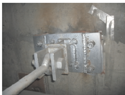
図-3 1号機の配管支持構造物の点検結果
