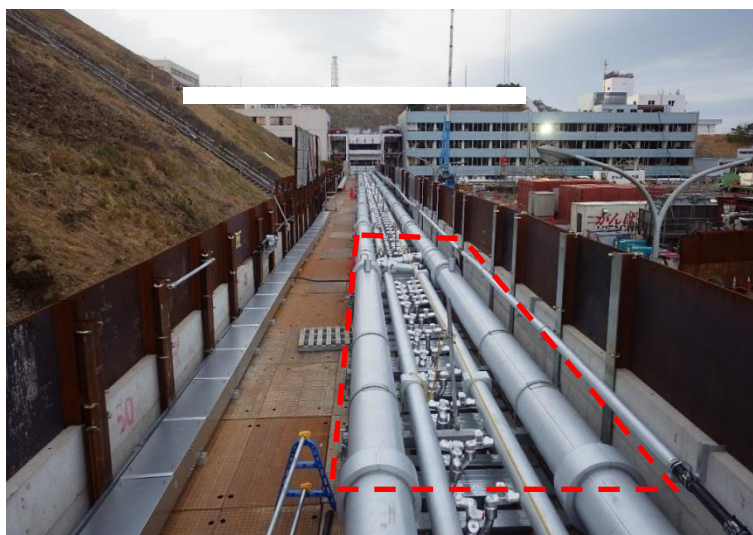
図－3 配管類撤去箇所の例
