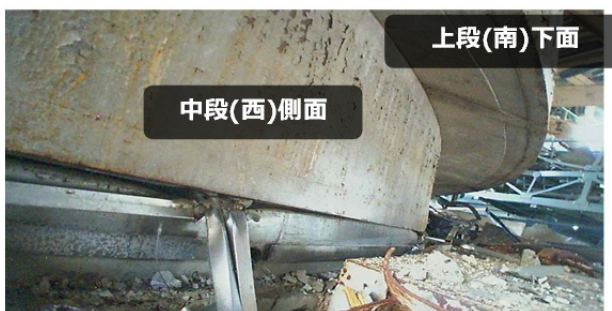
原子炉ウェルプラグ損傷状況
