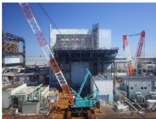
構台・前室設置状況（撮影日：3月11日）
