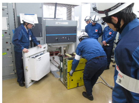
高圧または特別高圧電気取扱研修
