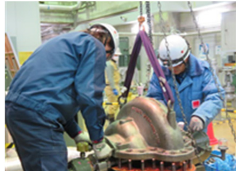
横型ポンプ分解点検訓練（ケーシング吊り込み）
