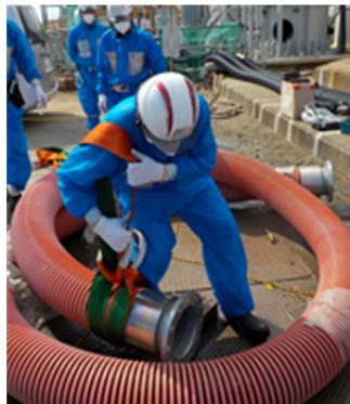
仮設ホース敷設・接続訓練（左：ホース移動敷設、右：フランジ接続）
