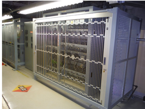
計装ラックへの防護柵の設置
