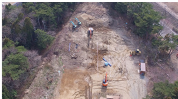
ドローンによる瓦礫撤去状況の確認
