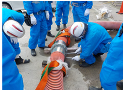
仮設ホース敷設・接続訓練（左：ホース移動敷設、右：フランジ接続）
