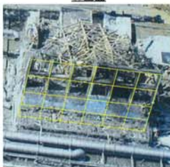
②東面 外壁
