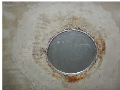
④ 鉄板閉止（閉止板も同様）
