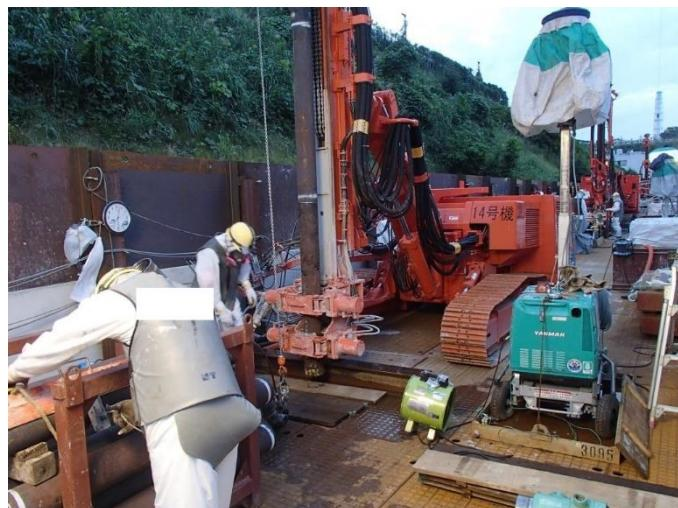
図-4 ボーリング削孔（イメージ）
