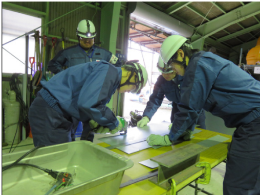
中央制御室空調ダクト補修訓練（左：あて板の切り出し作業、右：リベット打ち作業）
