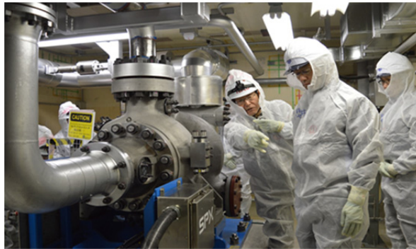
柏崎市長による現場確認 (7 号機高圧代替注水系ポンプ設置状況)
