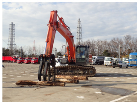
つかみ機を用いたがれき除去訓練 (柏崎刈羽)
