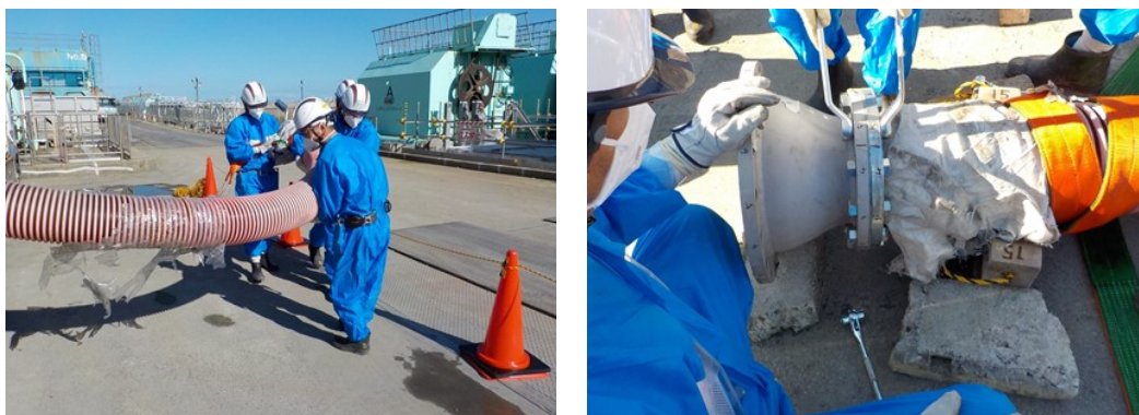
仮設ホース敷設訓練（左：ホース敷設、右：フランジ接続）
