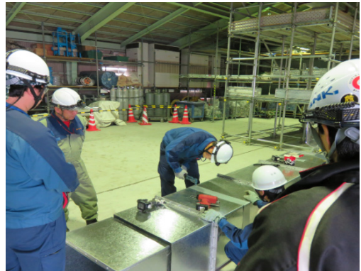
中央制御室空調ダクト補修訓練（左：あて板の切り出し作業、右：リベット打ち作業）
