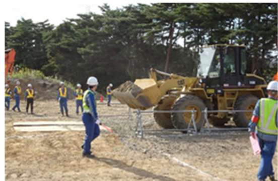
福島第一チームの作業（左：瓦礫①撤去業況、右：段差復旧用砂利運搬）
