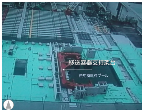
移送容器支持架台
