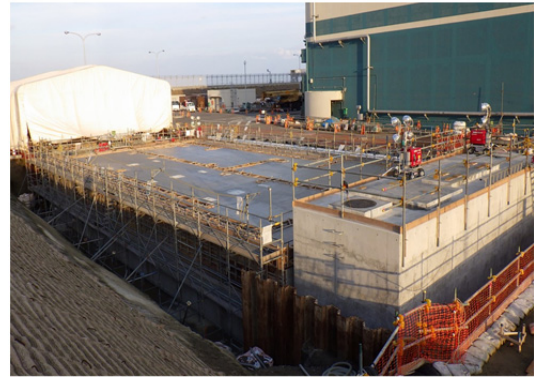
<コンクリート打設完了後>
