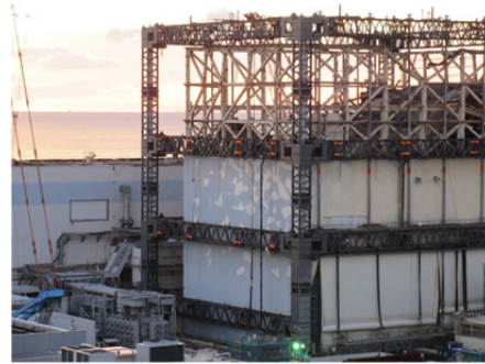
全壁パネル取り外し完了
