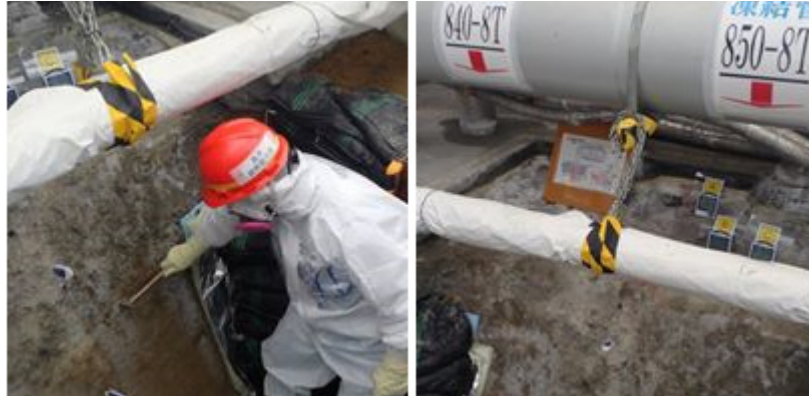
陸側遮水壁の凍結状況の目視（フェイスブックより）
