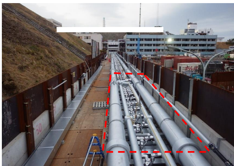
図－3 配管類撤去箇所の例
