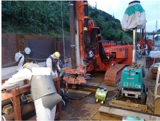
図-4 ボーリング削孔（イメージ）
