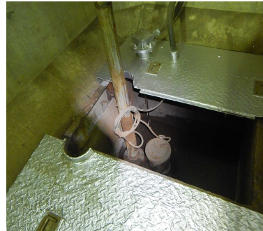
②排水ポンプの設置
