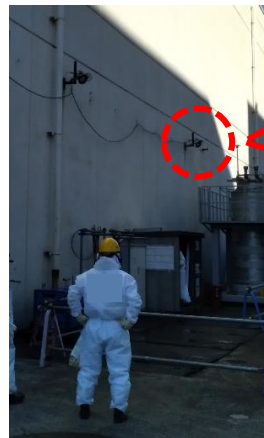
【現場状況（建屋外観）】
