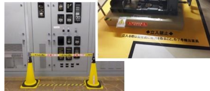
設備ガードの例
