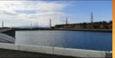
淡水貯水池設置
