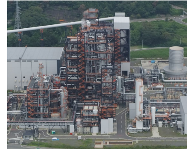
勿来IGCC発電所外観
