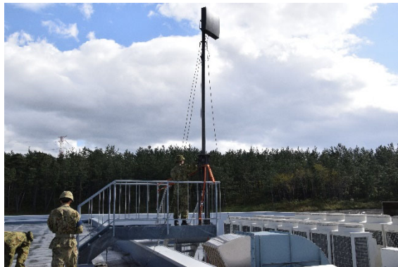
屋外アンテナの設置
