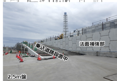
2.5m盤施工後（2022年9月）
