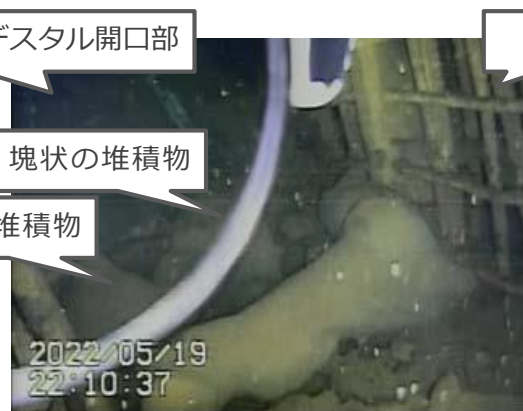
ペDESTAL開口部（内部手前）俯瞰
