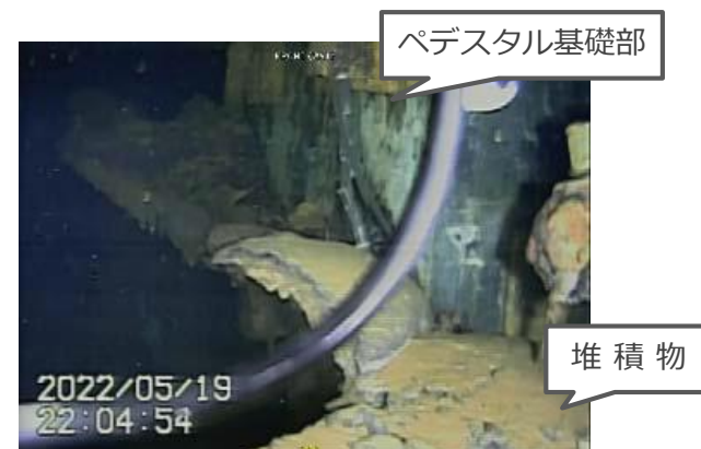
ペDESTAL開口部（右側基礎部）の堆積物より上部
