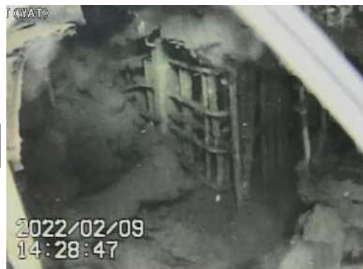
ペDESTAL開口部付近
