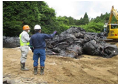
仮置場 施工中の状況確認
