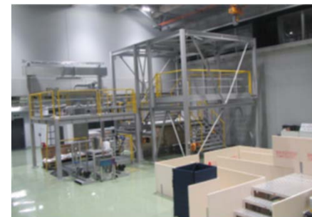
事務所棟 訓練施設
