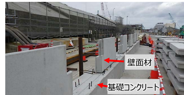
コンクリート壁面材設置状況 (9月27日撮影)
