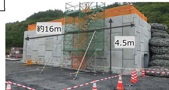
コンクリート壁面材の試験施工状況 (9月8日撮影)
