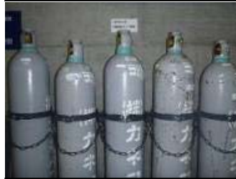
予備ポンベの配備
