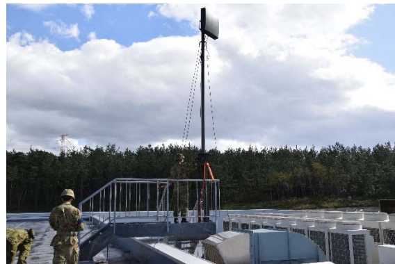
屋外アンテナの設置
