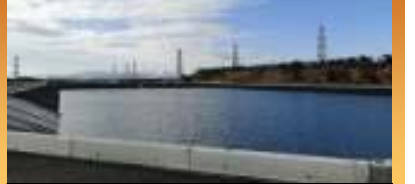
淡水貯水池設置
