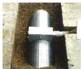
写真2 集水管敷設状況
