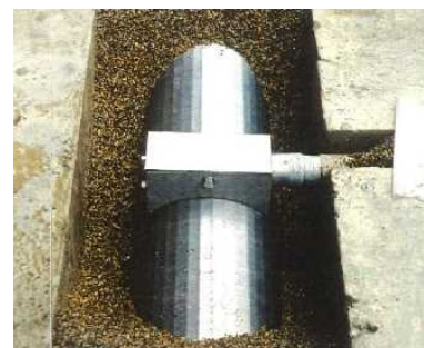
写真2 集水管敷設状況
