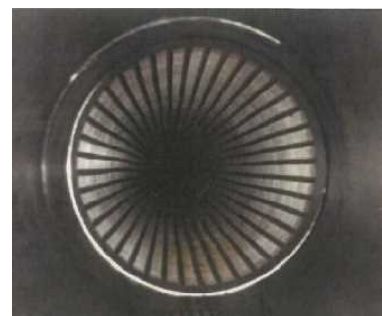
写真3 集水管内部
