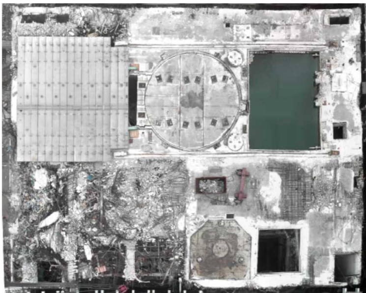
3号機オペフロ瓦礫撤去状況
