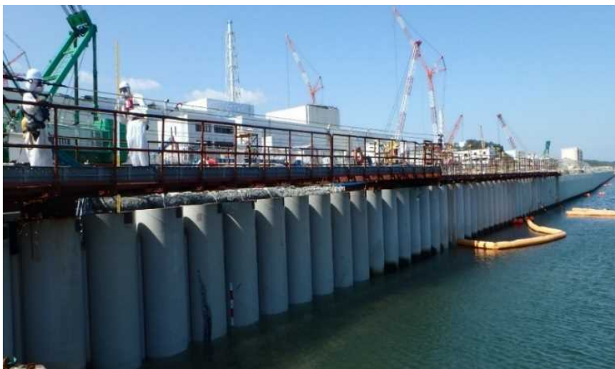
海側遮水壁設置状況
