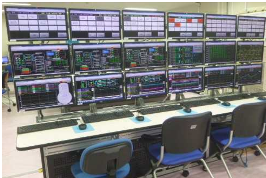
集中監視システム設置状況 (2015年2月)
