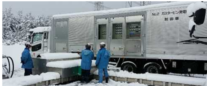
積雪時におけるGTG運転訓練
