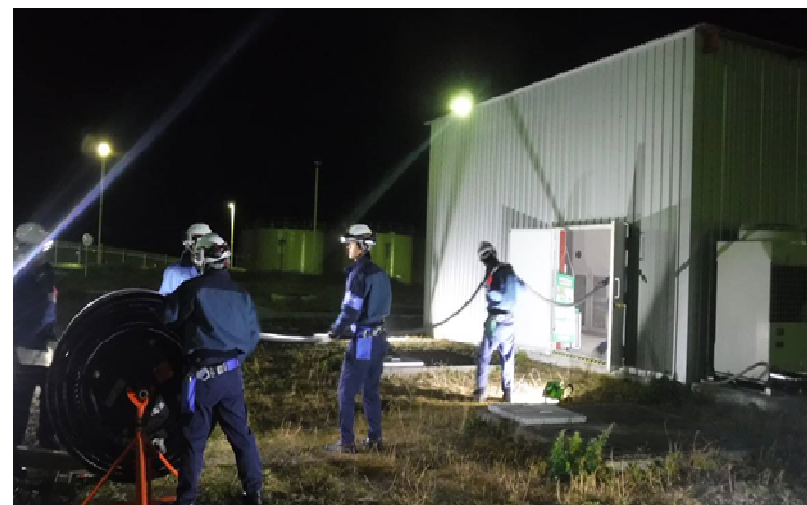
夜間のケーブル敷設訓練
