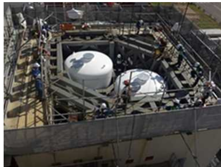
追加設置されたヨウ素フィルタ (無機および有機ヨウ素除去)
