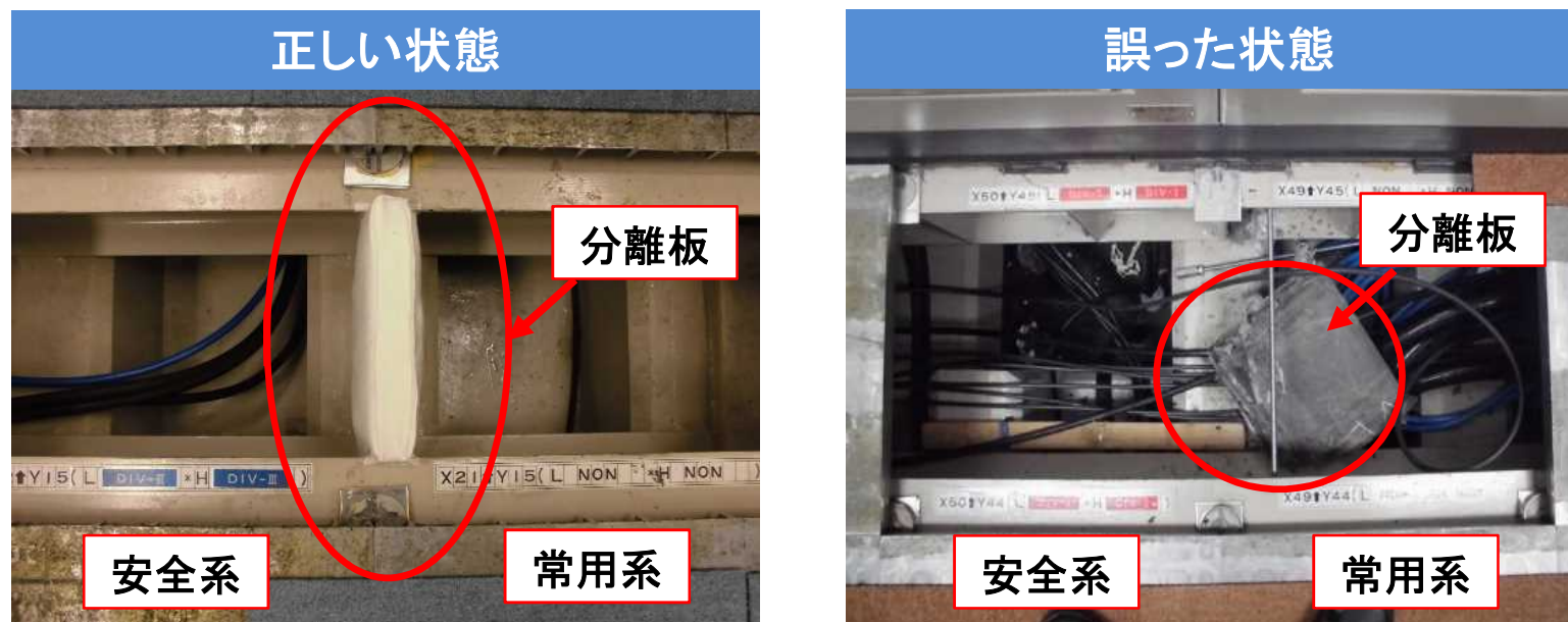
ケーブルの正誤状態
