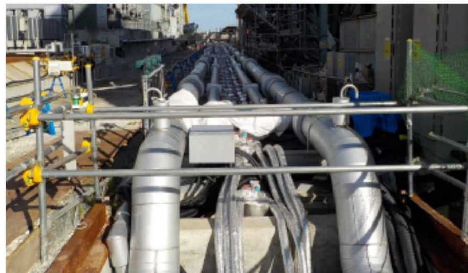
陸側遮水壁設置状況
