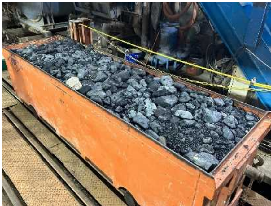
撤去作業の状況 （1日の作業での撤去状況 約3～4ton）
